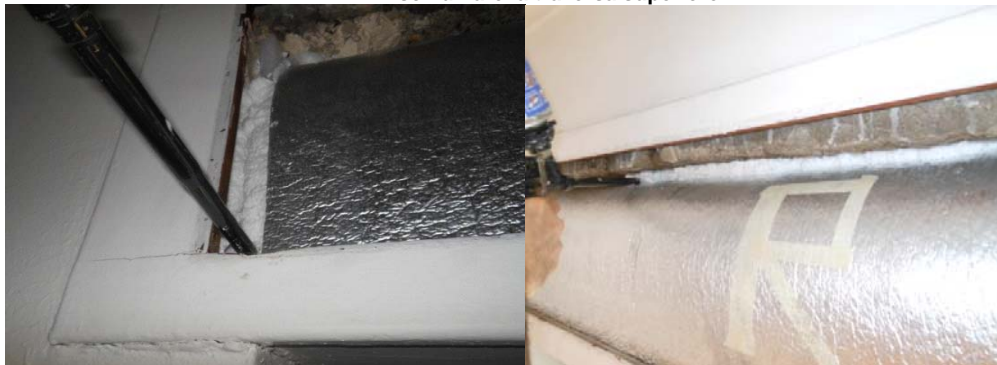
anche lungo i fianchi inserire il pannello frontale Flexoterm
